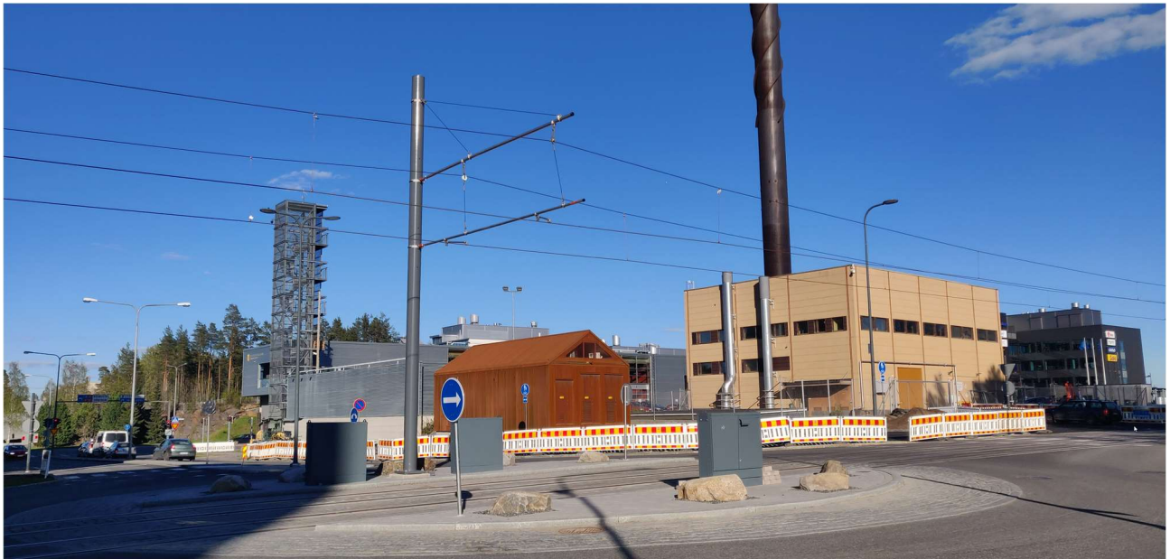
Kuva 10: Raitiovaunun ja ratajohtorakenteen sivukuva. Ylempi lanka on kannatinlanka, joka kannattelee ripustimilla ajolankaa.
